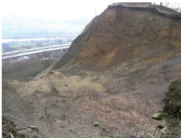
Obr. 4. Pohled do odlučné oblasti aktivního sesuvu v opuštěném lomu Prackovice (3 na obr. 1), kde byly identifikovány dva mělké dílčí sesuvy. Vlevo mezi suchou trávou je patrný pramen.
