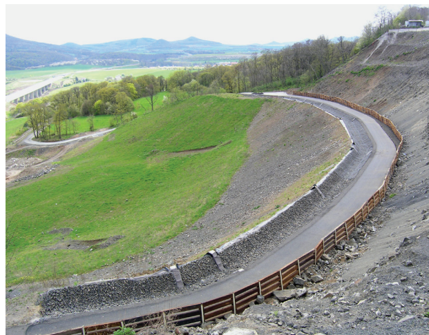
Obr. 2. Pohled na JJZ na sanovanou odlučnou oblast sesuvu z června 2013. Vpravo prostor lomu Dobkovičky.
