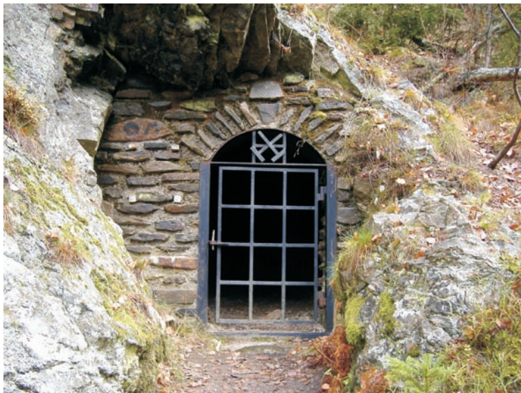
Obr. 1. Portál štoly Amáline údolí 1 v Kašperských Horách. Foto M. Poňavič.
