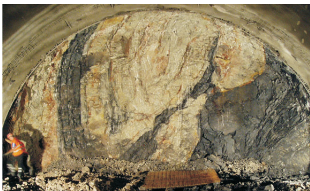
Snímky čeleb horní části (kaloty) jižního tunelu, pořízené během ražby. Poloměr tunelového oblouku je 6 m, směr pohledů od VSV k ZJZ. Foto E. Straka.
