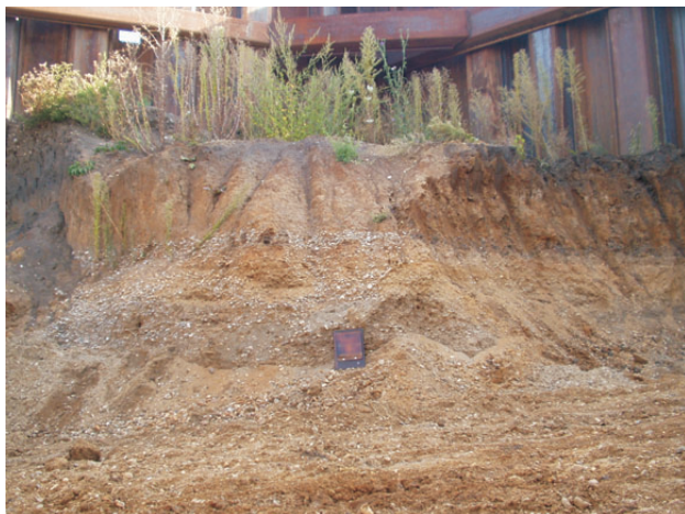
Obr. 1. Malá vodní elektrárna Bulhary – výkop základů; pod povodňovými hlínami jsou svrchnopleistocenní až holocenní fluvialní písčité štěrky vyplňující dno nivy Dyje.
