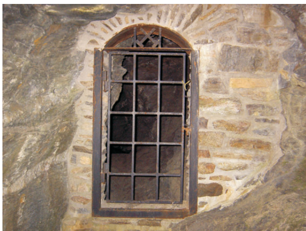
Obr. 4. Zajištění štoly v lokalitě Amáline údolí, stav v roce 2007. Foto M. Poňavič.
