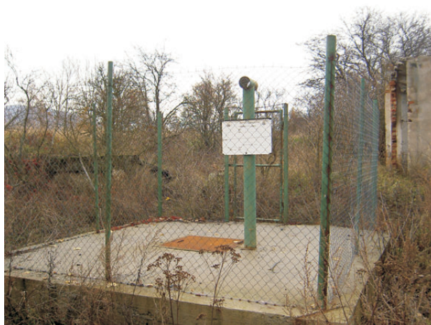
Obr. 1. Zajištění větrné jámy č. V dolu Jan v roce 2006. Foto M. Poňavič.
