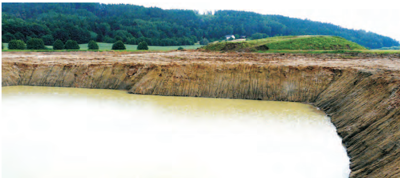
Obr. 1. Pelitická sekvence v nadloží jizerského souvrství v částečně zatopeném výkopu pro stavbu wellness centra „Termální ráj Všeň“, dokumentační bod CV024 (list 03-341 Kněžmost). Foto J. Valečka.
