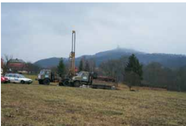
Obr. 2. Hloubení mapovacího vrtu Bo-1 Borek.
