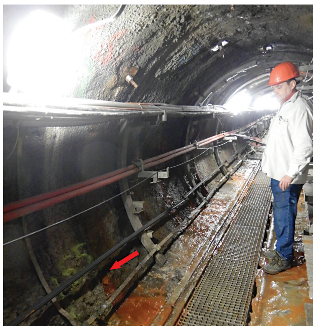
Obr. 4. Celkový pohled na první skupinu vývěrů v okolí přítoku v úseku 54,5 m po rekonstrukci. Foto V. Goliáš.
