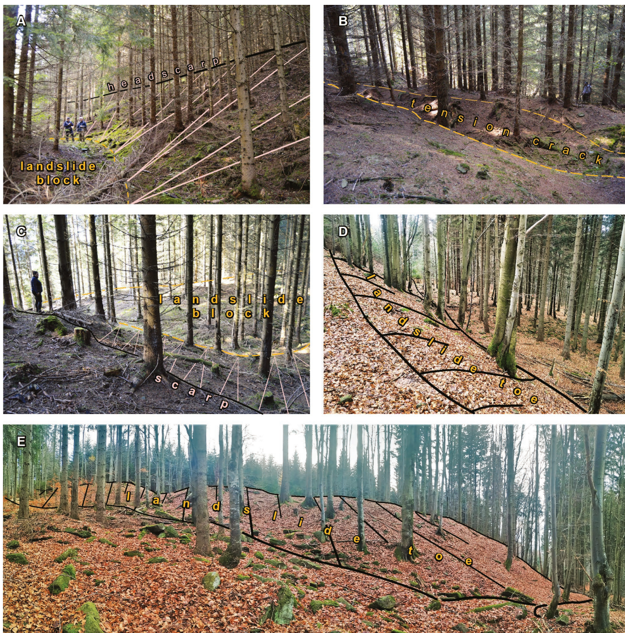
Obr. 2. Charakteristické prvky sesuvu: A – morfologicky nejvýraznější odlučná část sesuvu nad lesní cestou; B – tahové trhliny v transportní části sesuvu nad dokumentačním bodem (DB) 5; C – nejnižší odlučná část sesuvu s výrazným sesuvným blokem; D, E – pohled na východní část čela sesuvu. Foto M. Kašing.
